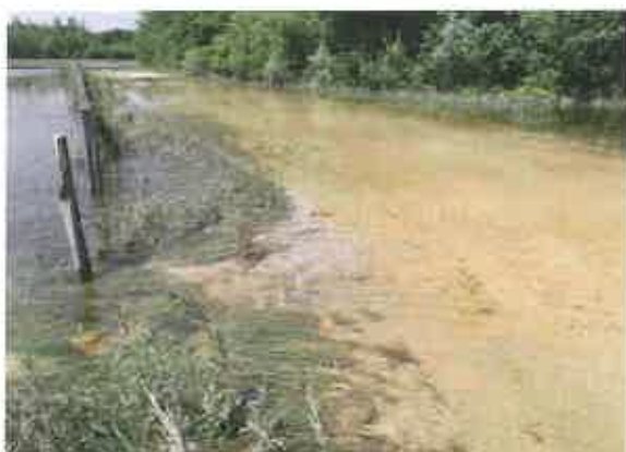
Fig. 8 : Le 3 juin 2013, courant provenant de la prairie du CG77 et se déversant dans la « bassine » A2C. Vue sur l'érosion de l'accotement...
