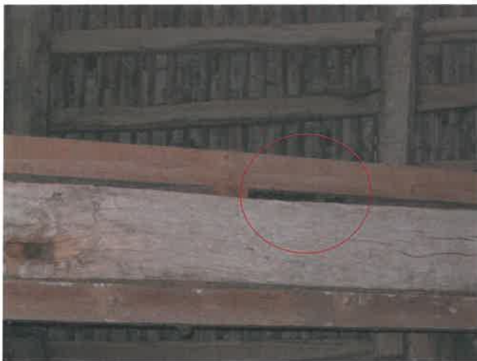
Localisation d'un site de reproduction du Murin de Daubenton entre deux poutres à la ferme d'Isle (Grisy-sur-Seine)
