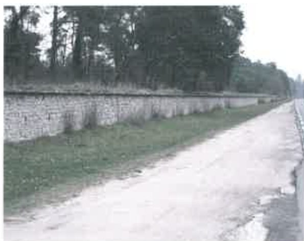
Le mur, côté route d'Orléans
