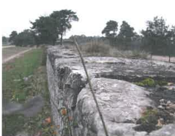
Le mur, côté Sud.
