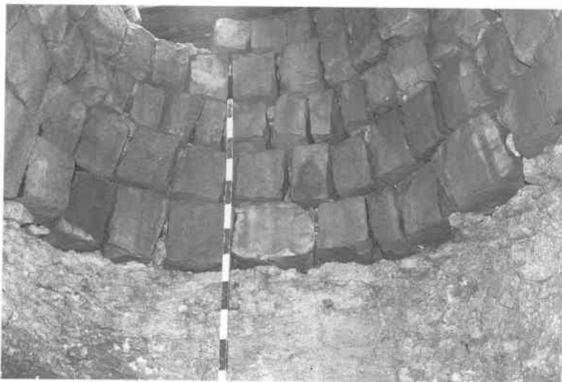
Figure 4.- Appareillage, en blocs de grès, de la coupole du puits d'accès (cliché G. R. Delahaye).
