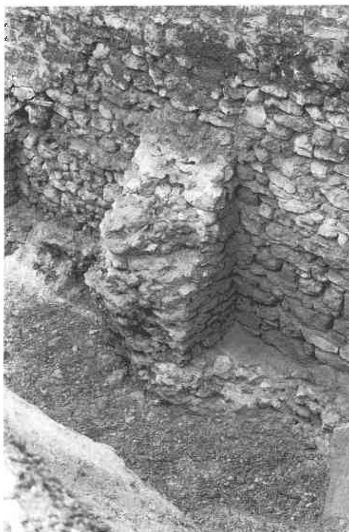
Fig. 6.- L'un des contreforts externes du mur ouest du hangar (cliché G. R. Delahaye).
