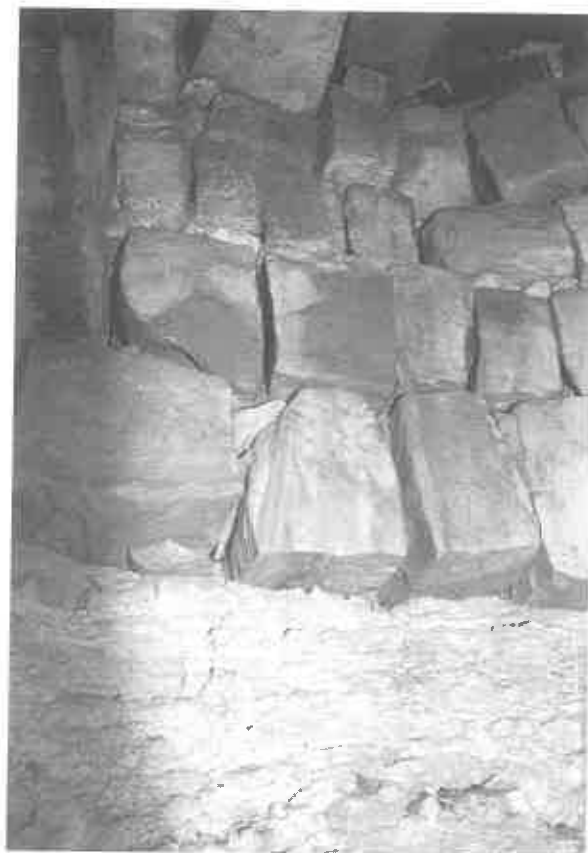
Figure 3.- Détail de l'appareillage de la coupole du puits d'accès (cliché F. du Retail)
