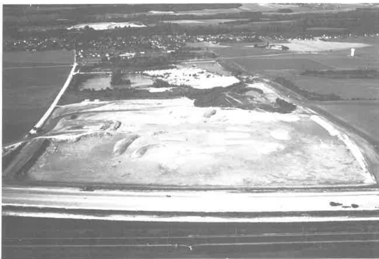
Photo 2 : Vue aérienne du site en fin d'exploitation (Septembre 1992)
