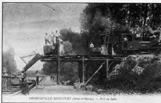
Déchargement de wagonnet de sable au port de Fromonville. Extrait de Chaintreau (1989).
