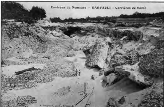
Carrière du Château ? Vue générale qui montre bien les dalles superposées et les morphologies de dissolution au sommet de la dalle supérieure. Noter aussi l'amoncellement de stocks importants de pavés. Ce stock résulte probablement du volume important des dalles grès par rapport au sable et peut-être aussi à la difficulté d'écouler les grès. Extrait de Chaintreau (1989).
